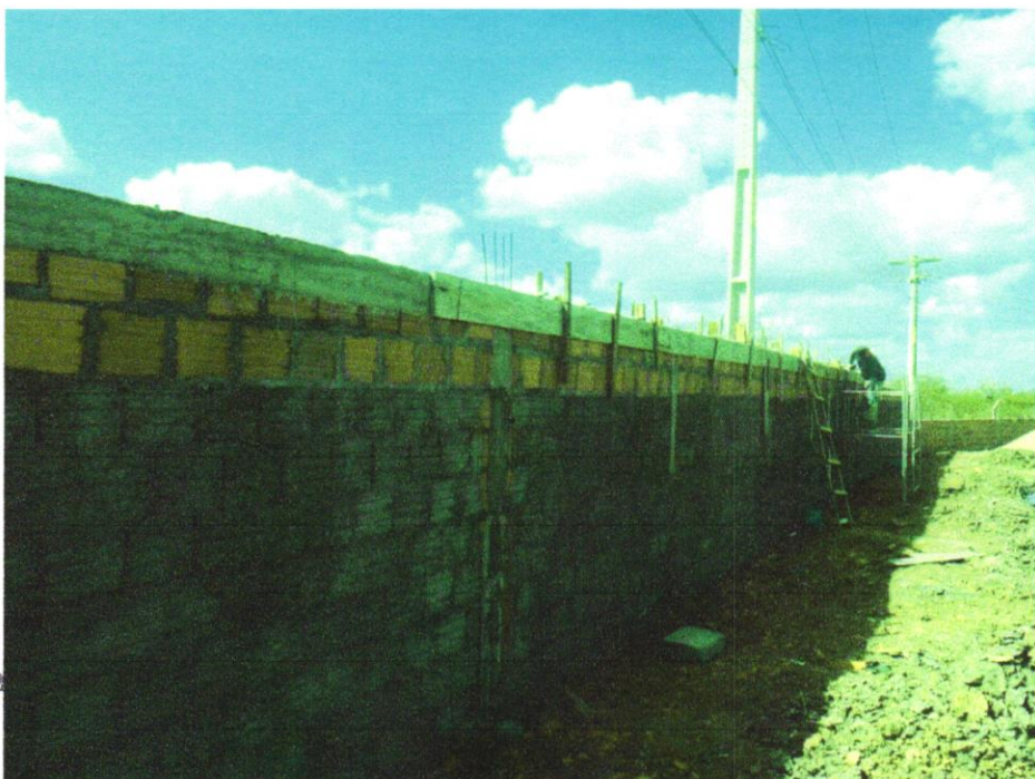
Foto 06 - (COMPOSIÇÃO REPRESENTATIVA) EXECUÇÃO DE ESTRUTURAS DE CONCRETO ARMADO, PARA EDIFICAÇÃO INSTITUCIONAL TERREA, FCK = 25 MPA. AF_01/2017
