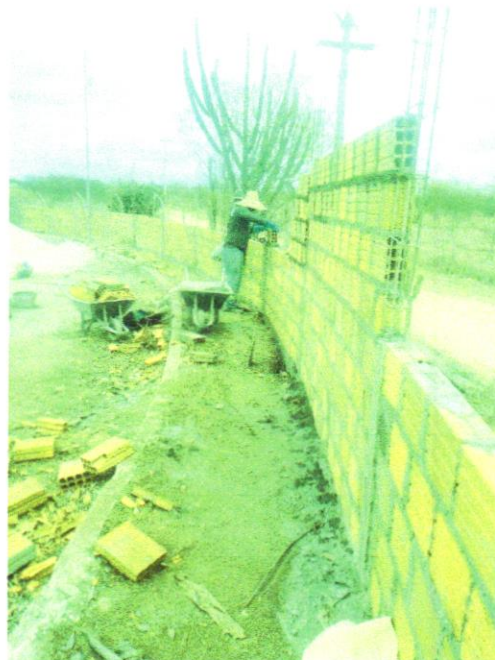
Foto 02 - ALVENARIA DE VEDAÇÃO DE BLOCOS CERÂMICOS FURADOS NA VERTICAL DE 9X19X39 CM (ESPESSURA 9 CM) E ARGAMASSA DE ASSENTAMENTO COM PREPARO EM BETONEIRA. AF_12/2021
